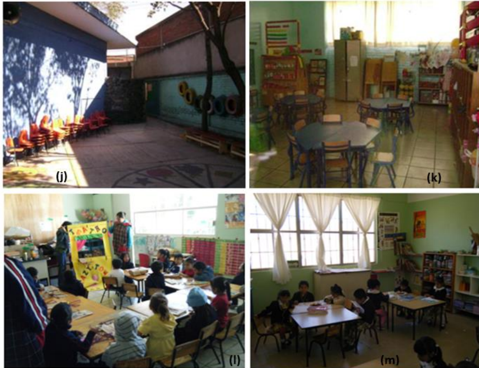
Figura 5. Áreas de casas adaptadas para funcionar como espacios educativos, carentes de cumplimiento normativo en iluminación, ventilación, mobiliario y áreas comunes para impartir clases a nivel de educación preescolar
